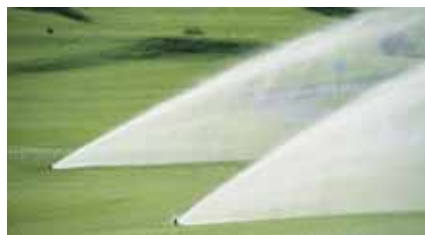
Perfekte Wasserverteilung im Nahbereich durch Diffusoren.
